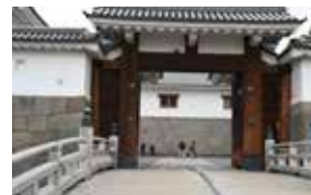
東御門橋は路面が木製の太鼓橋
